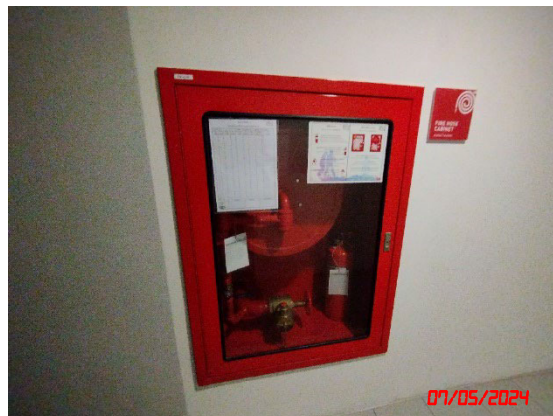
ตู้เก็บสายรับน้ำดับเพลิง
